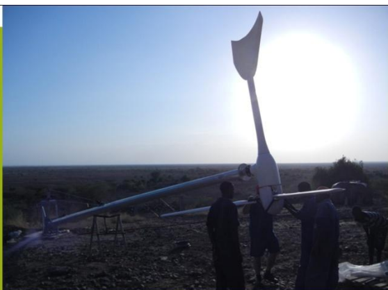
Instalación de la turbina completada. Listo para izar la torre.
