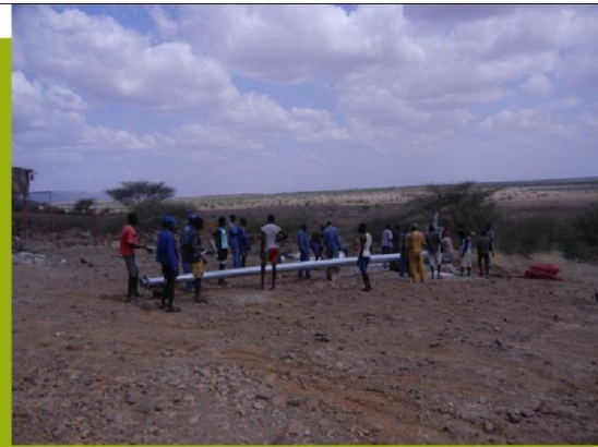
Torre y sistema de elevación totalmente instalados
