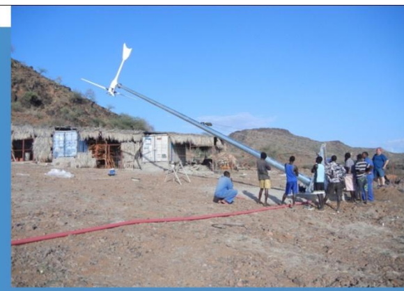
Iniciando el proceso de izado de la torre.
